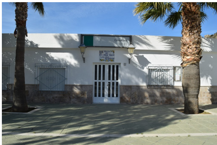
Puerta de acceso al C.S El Saltador
