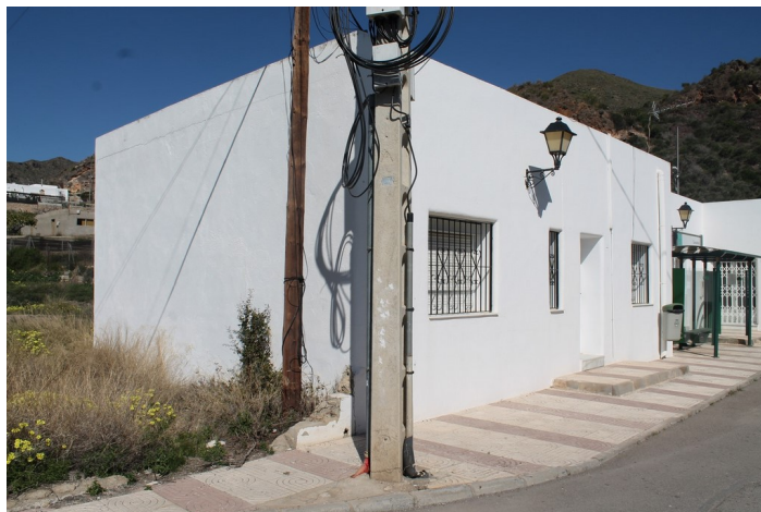
Fachada Vivienda Social en Cueva del Pájaro
