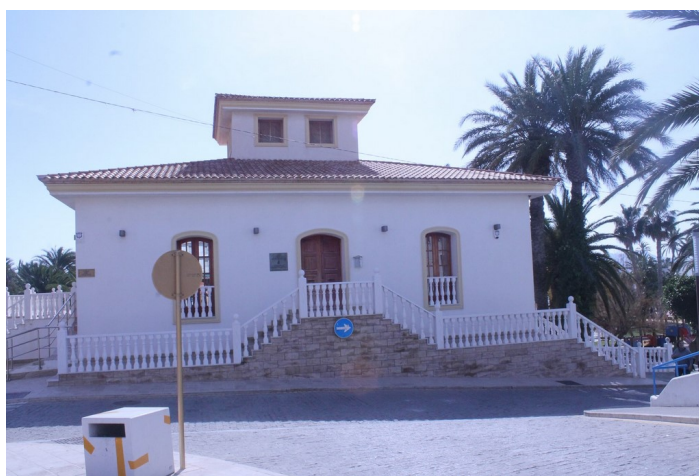
Fachada Casa de las Tejas desde Plaza Castillo
