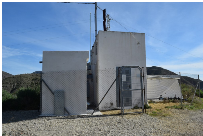
Caseta y Depósito Saltador Bajo
