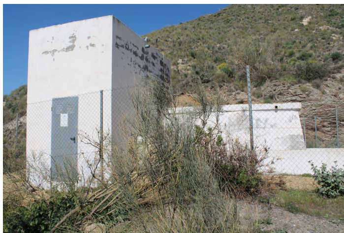
Depósito de agua Cueva del Pájaro
