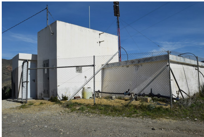
Caseta y Depósito Saltador Bajo
