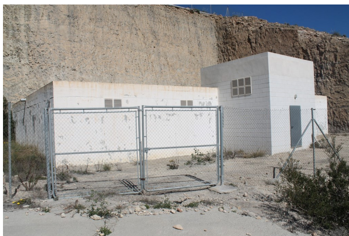
Depósito de agua SI-2
