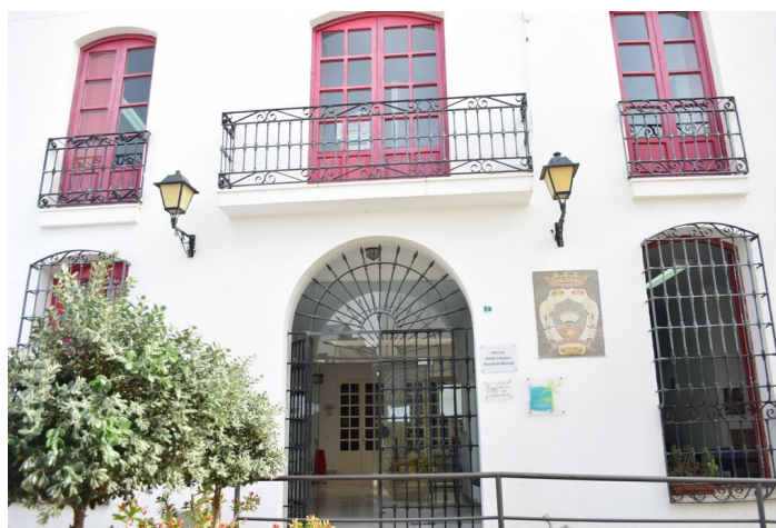
Fachada del Centro de la Tercera Edad
