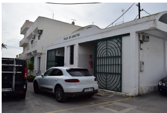
Fachada trasera Mercado de Abastos
