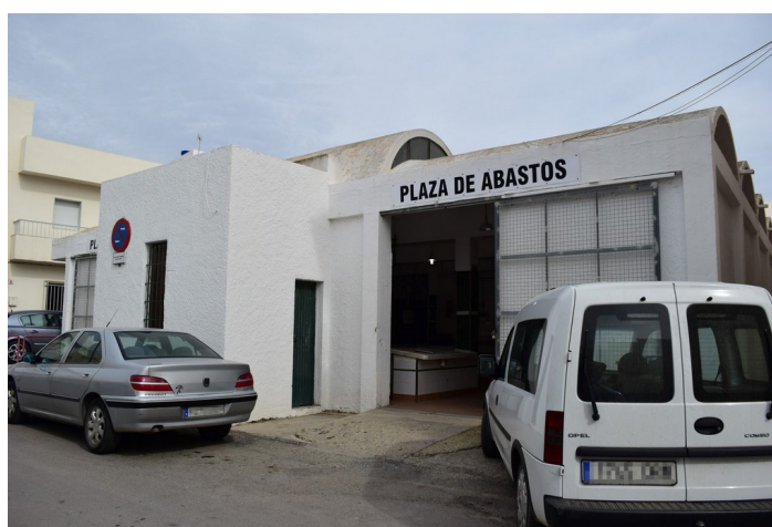
Fachada delantera Mercado de Abastos
