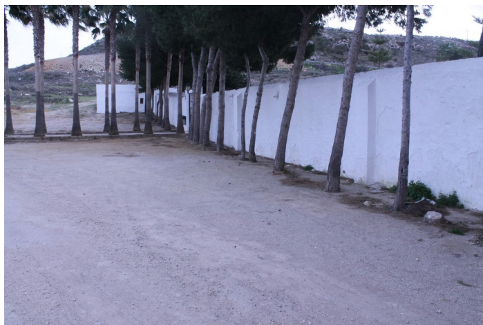
Muro del cementerio
