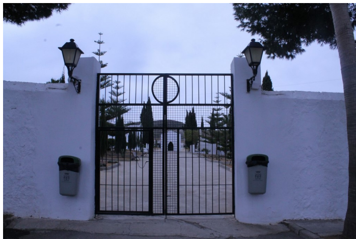
Entrada al Cementerio San JosÃ©
