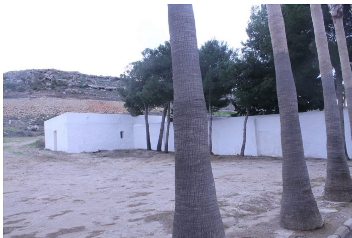
Caseta de aperos del Cementerio de San José
