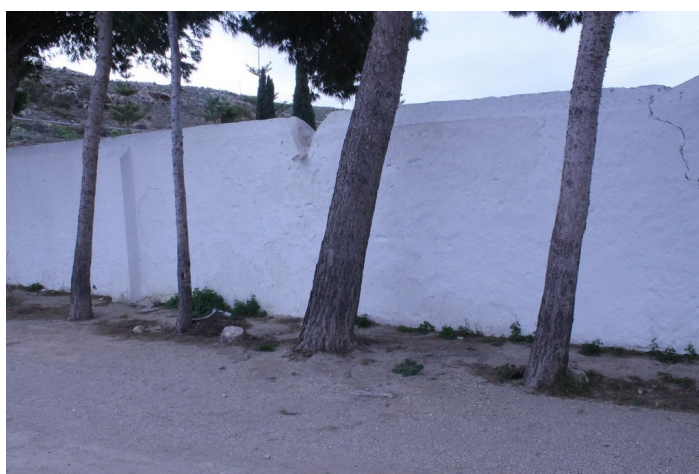
Muro perimetral del cementerio
