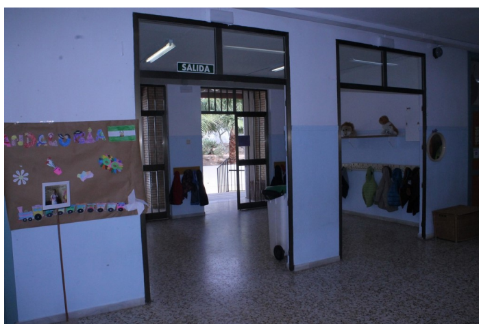
Acceso del edificio de infantil
