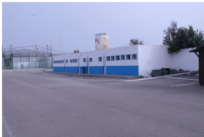
Edificio de vestuarios
