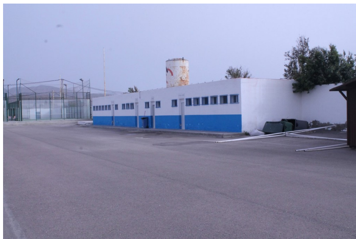
Edificio de vestuarios
