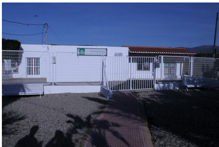
Fachada C.I. Llano de Don Antonio desde el exterior
