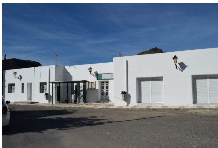
Fachada C.S. La Rambla
