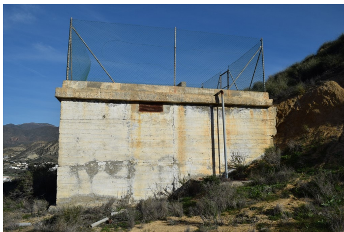
Depósito de agua La Islica desde la derecha
