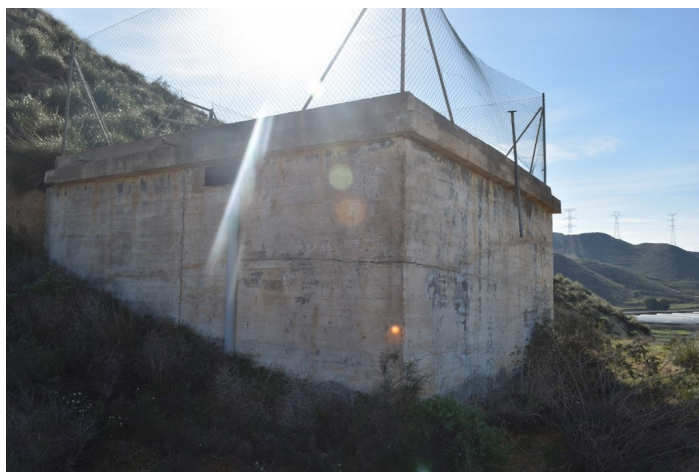
Depósito de agua La Islica desde la izquierda
