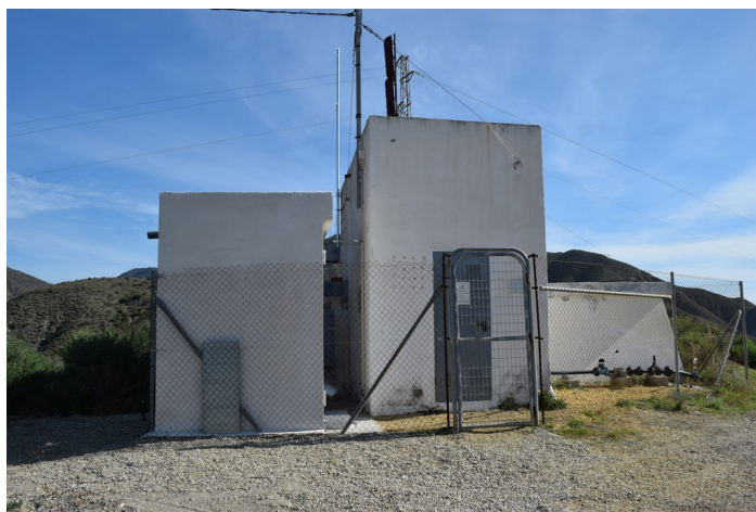
Caseta y Depósito Saltador Bajo
