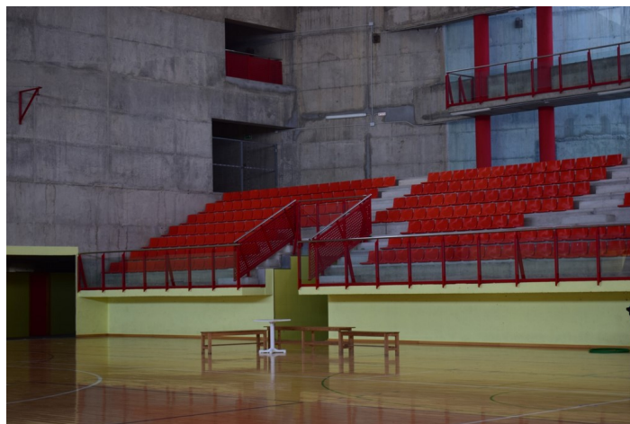
Gradas de la pista polideportiva del Pabellón Municipal
