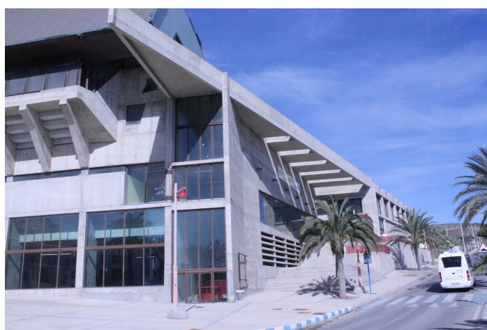
Fachada Pabellón Municipal en esquina
