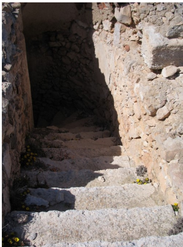
Escaleras de la cubierta
