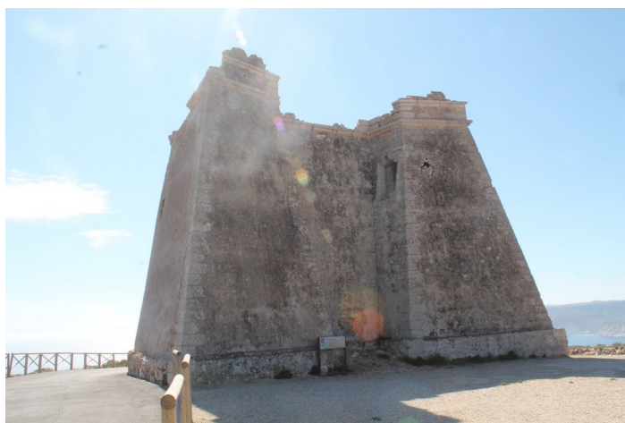
Fachada de torres
