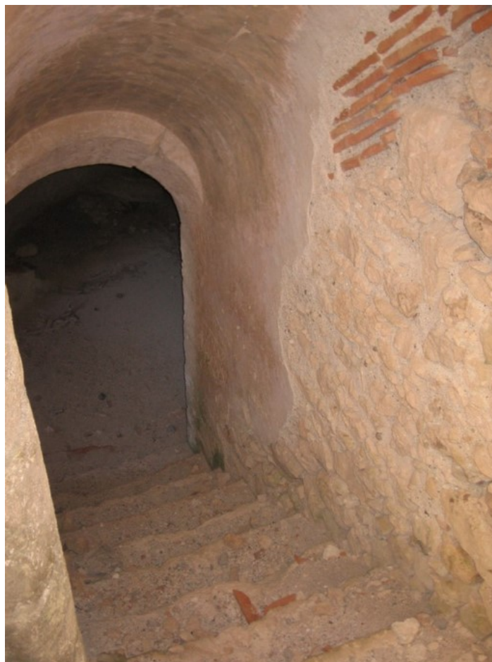
Bajada de escaleras
