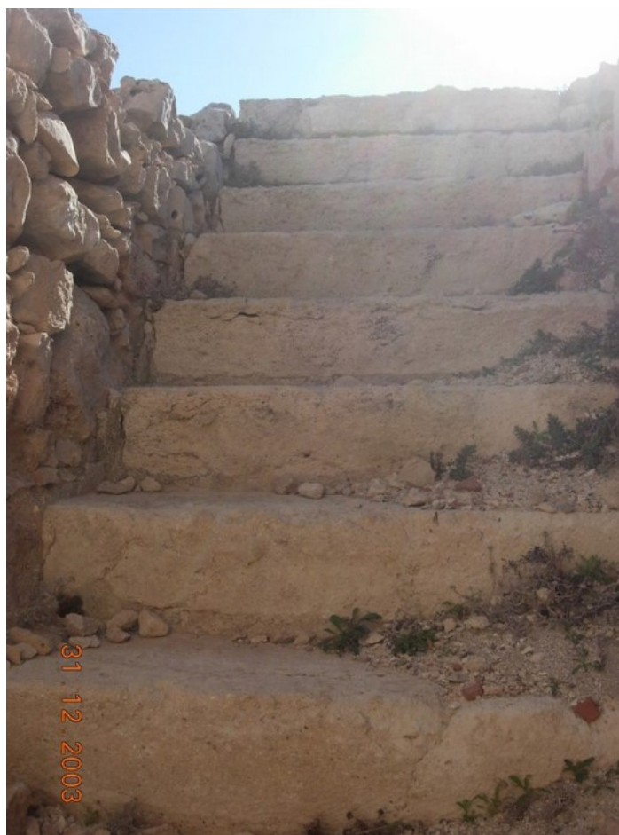
Escaleras que suben a la cubierta
