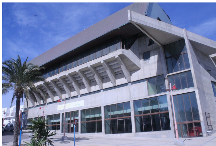
Solar Pabellón Municipal
