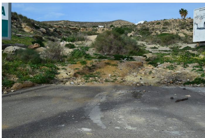
Calle Salinicas en construcción
