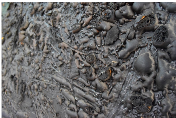
Detalle de obra
