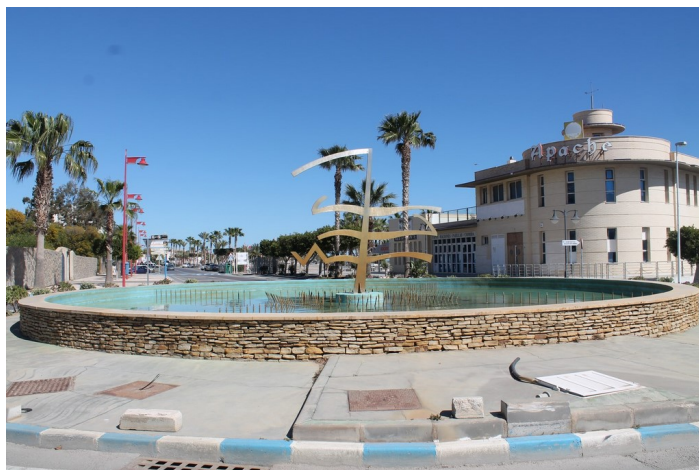
Obra vista desde el frente
