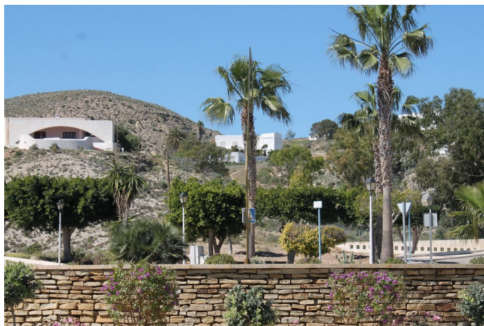
Obra vista desde el lateral
